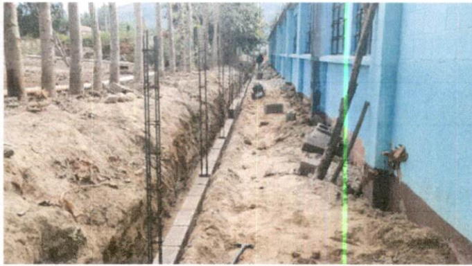
Foto1: Mejorando el muro perimetral del lado norte del instituto.
