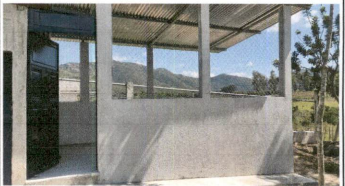
Foto 4: Instalando una puerta de metal en la cocina.
