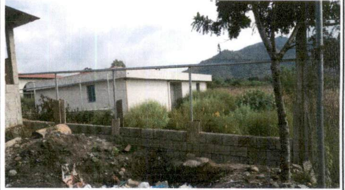
Foto 2: Mejorando el muro perimetral del lado este del instituto.
