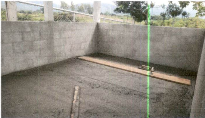
Foto 3: Mejorando la losa de piso en la cocina.
